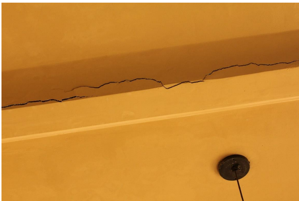
FOTO 06: Fissura no reboco sob viga metálica.
