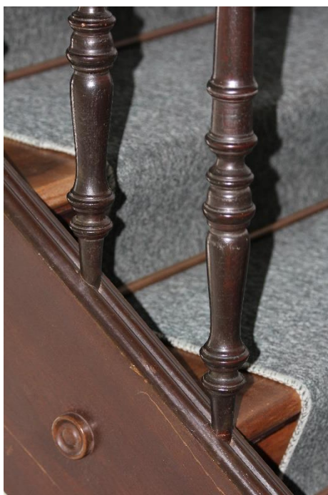
FOTO 18: Detalhe dos degraus, balaustrada e banzo em madeira.
