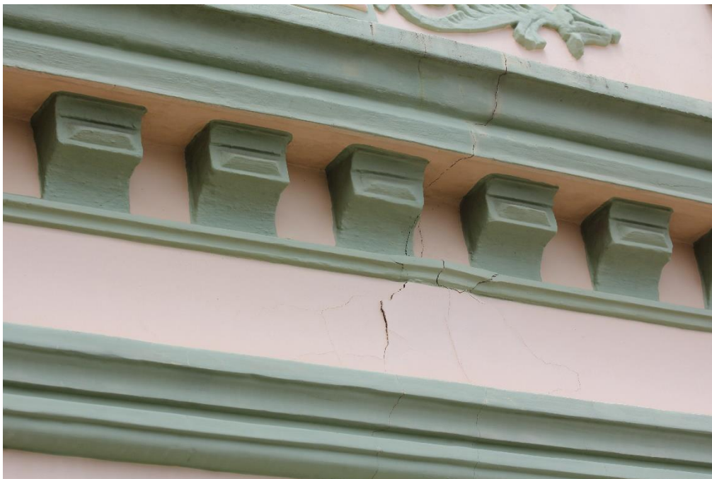
FOTO 07: Fissura e deslocamento de reboco nos ornamentos da fachada.
