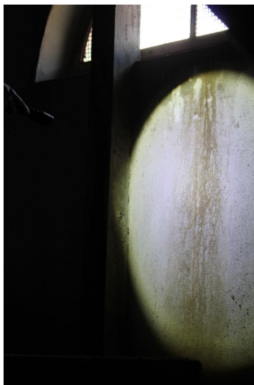
FOTO 12: Sinais de infiltração abaixo da janela do sótão.
