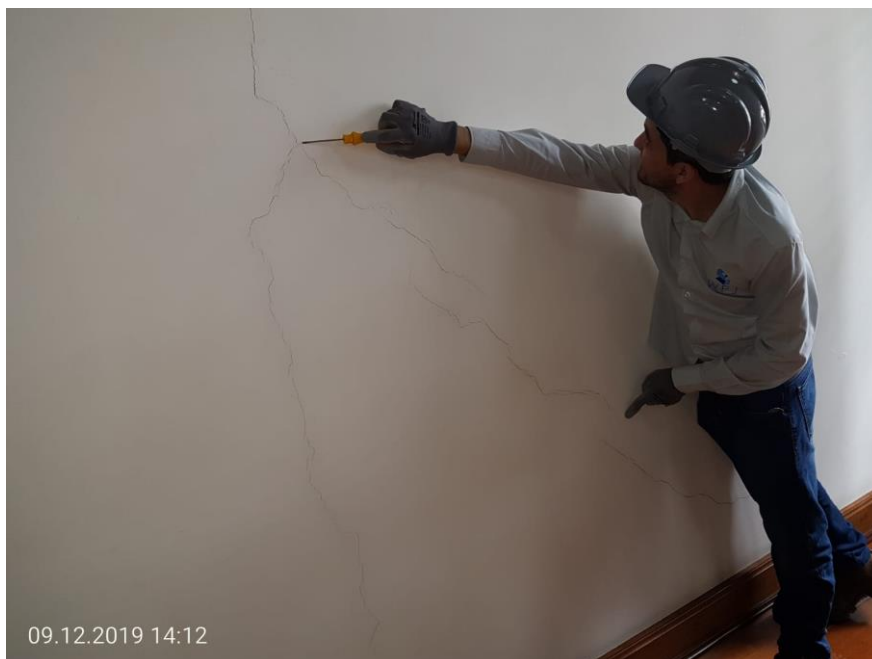
FOTO 05: Fissura em parede interna.
