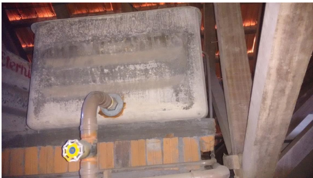
FOTO 19: Caixa d'água de fibrocimento e ligação ao barrilete.
