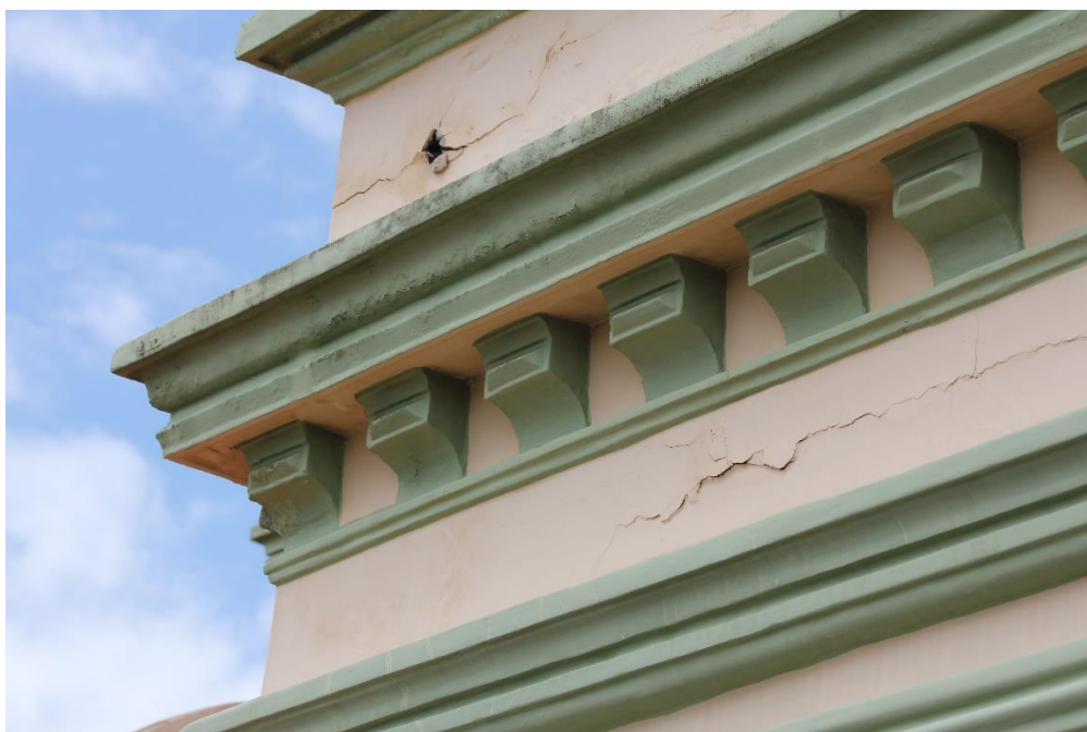
FOTO 08: Fissura e deslocamento de reboco nos ornamentos da fachada.
