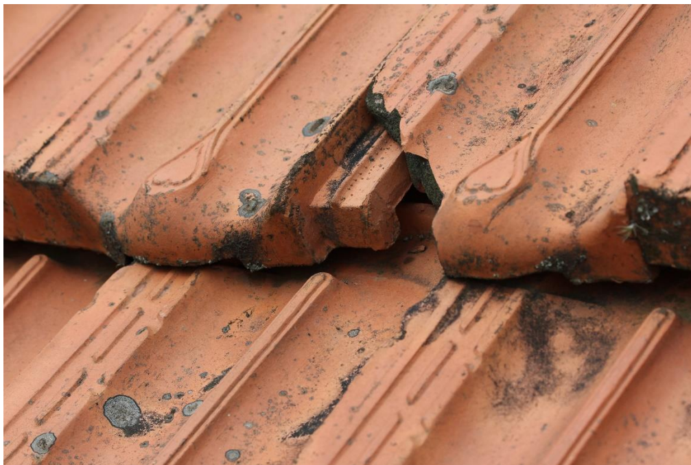
FOTO 03: Detalhe das telhas francesas e elemento quebrado.
