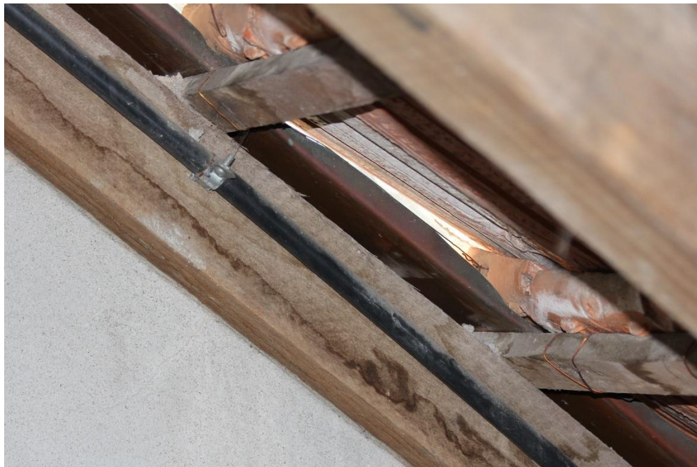
FOTO 11: Esmagamento da calha sob o telhado.
