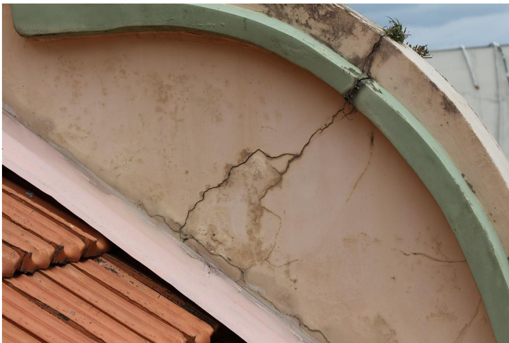
FOTO 09: Fissura no frontão da fachada.
